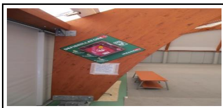
ATRIO D'INGRESSO PALESTRA/TENSOSTRUTTURA
