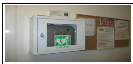
ATRIO INGRESSO PALAZZETTO SPORTIVO
